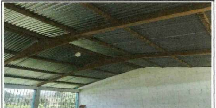
Foto 6: La fotografía evidencia la necesidad de cambiar las costaneras de madera porque están deterioradas, calan agua bajo los clavos de las láminas.
