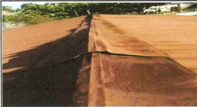
Foto1: La fotografía evidencia la necesidad de cambio de techado de las aulas.
