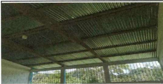
Foto 5: La fotografía evidencia la necesidad de cambiar las tijeras de madera porque están deterioradas.
